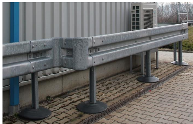
Anfahrerschutz für eine Klimaanlage sowie Hallenschutz
